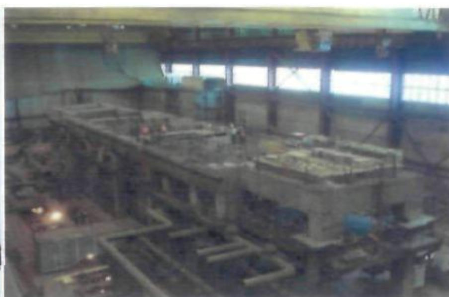
Усиление фундаментов турбоагрегата
